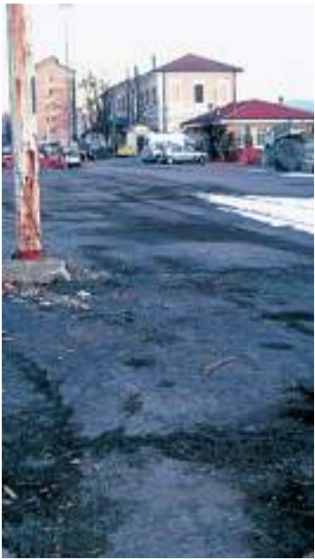
Stazione Fs, l'area parking
