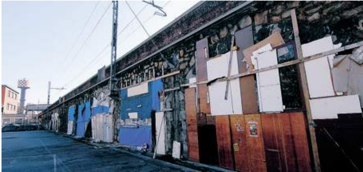
Baracche di rom ricavate sotto le campate del ponte ferroviario a Cornigliano
