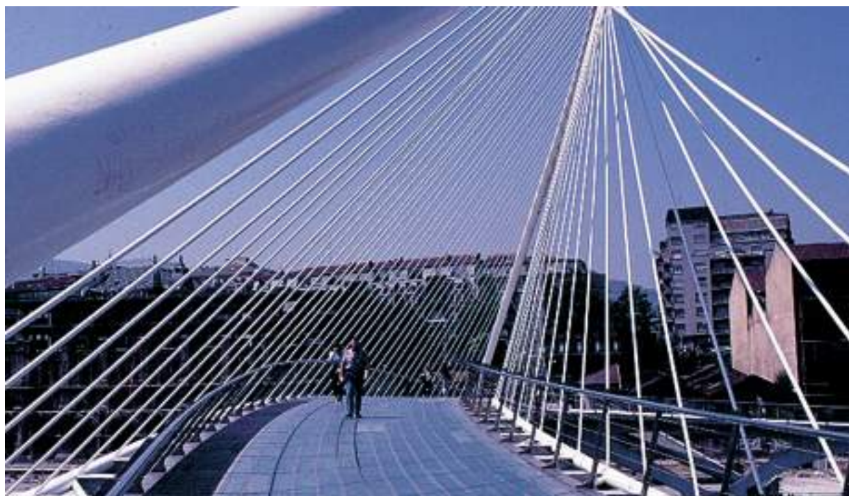
Il ponte disegnato da Santiago Calatrava a Bilbao, al centro della contesa con l'amministrazione cittadina
