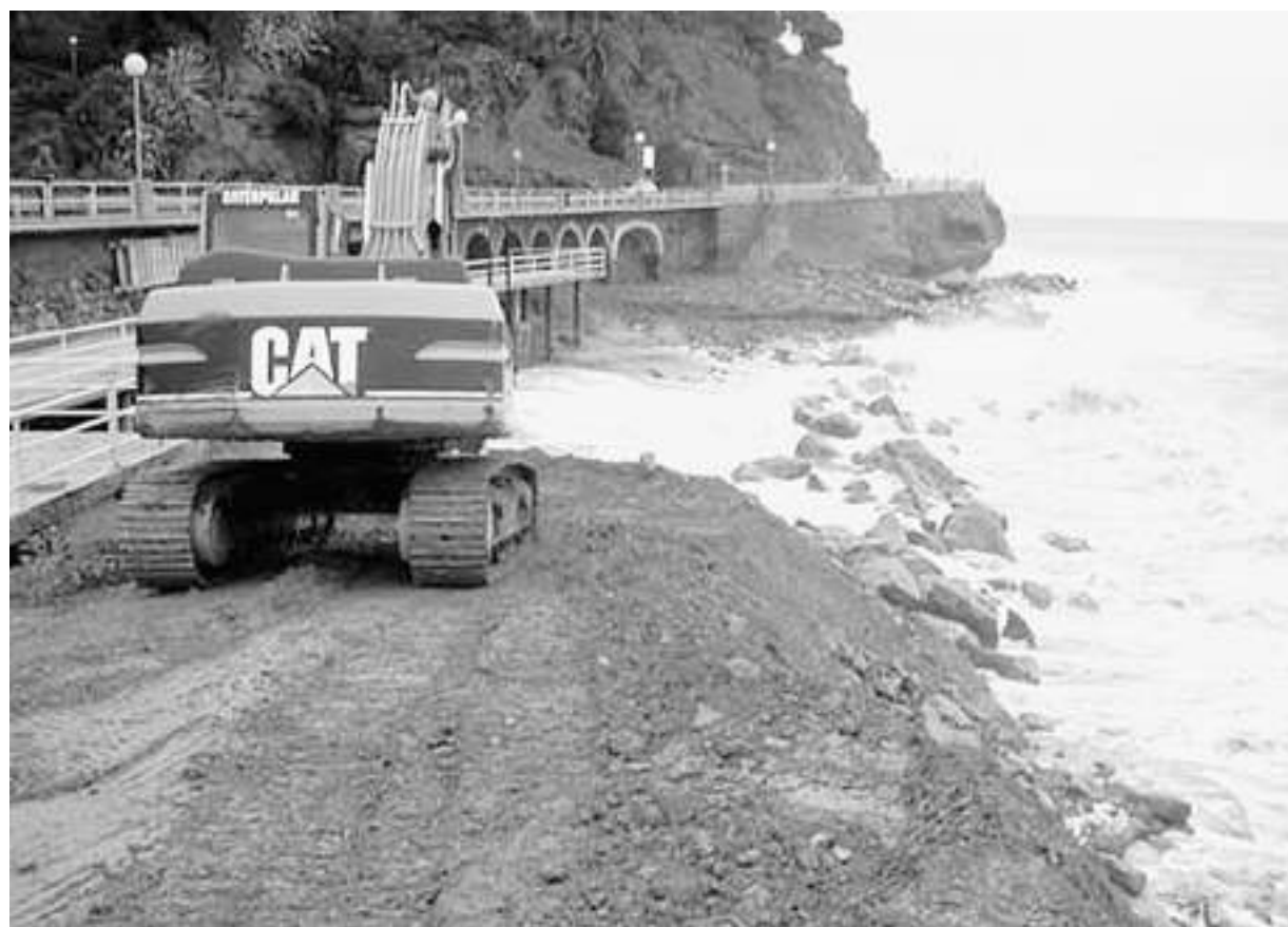
Una ruspa della Cofor impegnata nella costruzione del molo di Celle Ligure
