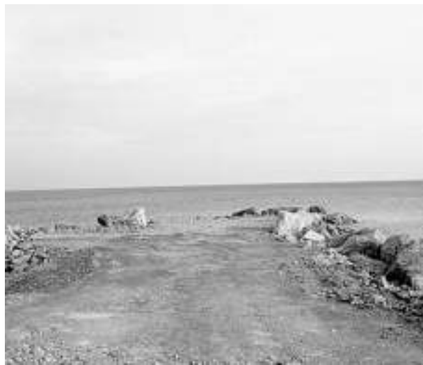
Cogoleto, le opere di protezione della costa
