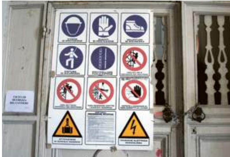
L'uscita di sicurezza del cantiere bloccata da lucchetti e catene
