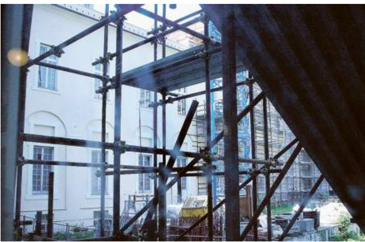
Il cantiere aperto nell'Albergo dei poveri, sede della facoltà di Scienze politiche dell'Università di Genova
