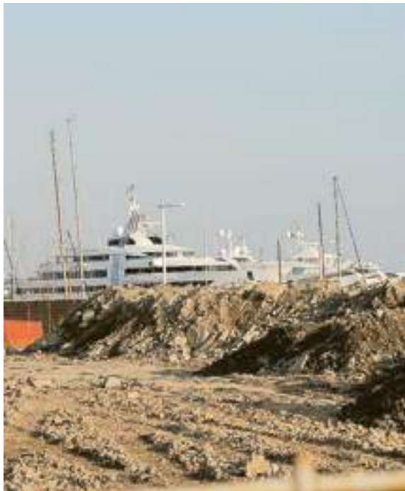
Lavori in corso nel porto turistico
