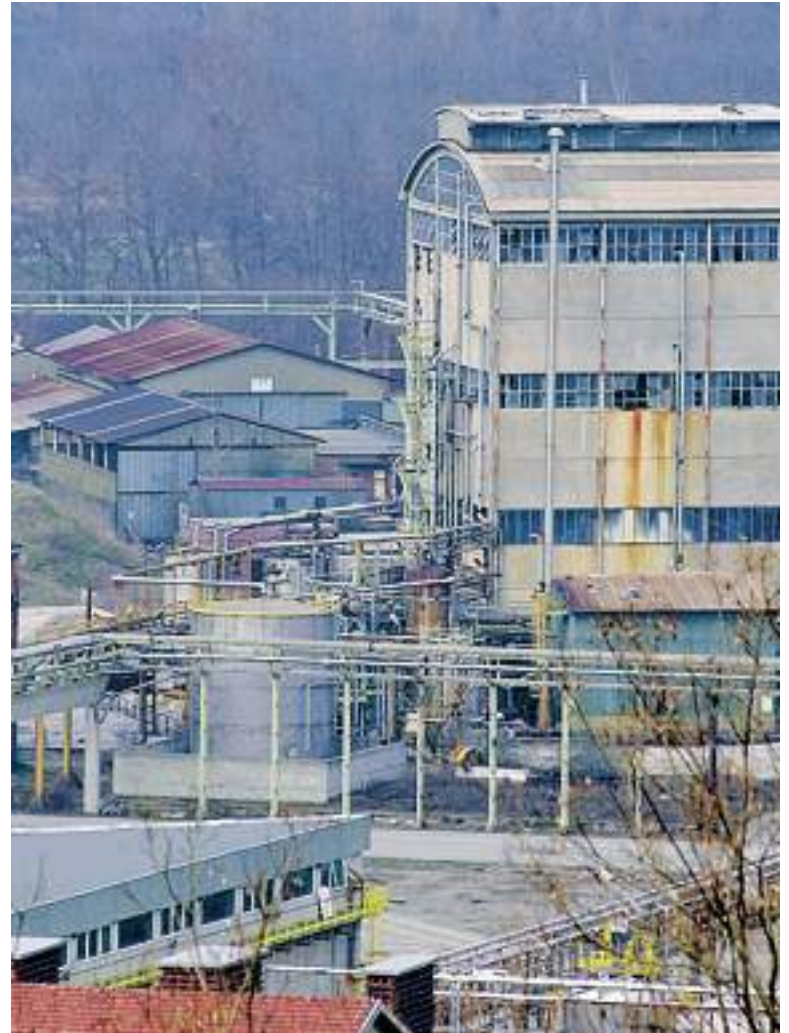
Gli impianti dell'ex Acna, la bonifica verrà ultimata a metà 2008
