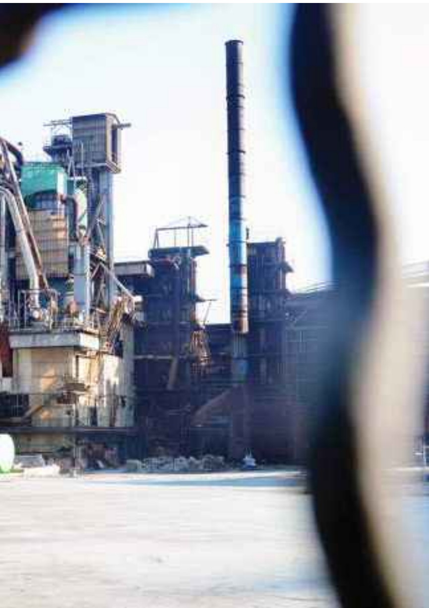
L'operazione consentirà la demolizione di parte dello stabilimento FORNETTI
