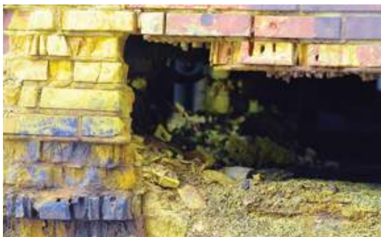
Un muro completamente intriso di cromo
