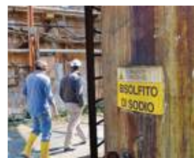
Cisterna di bisolfito di sodio
