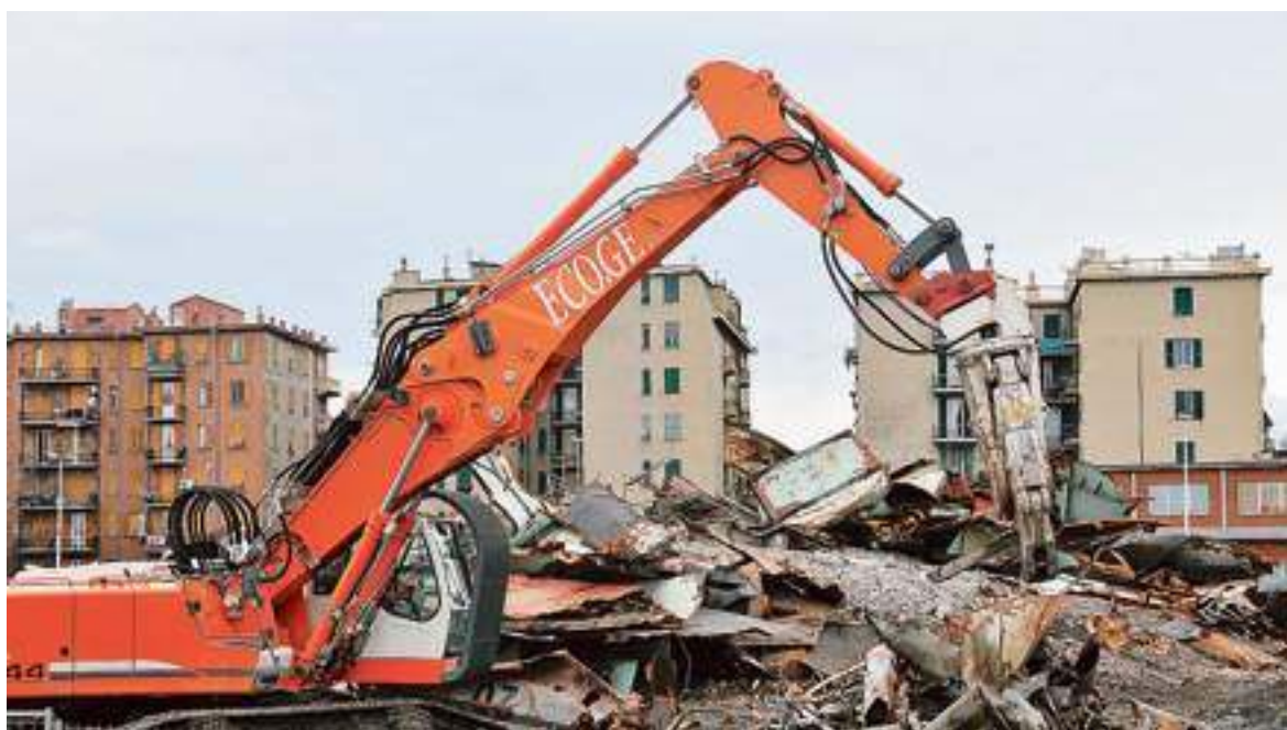
Un escavatore della Ecoge impegnato nella bonifica di un'area industriale dismessa
